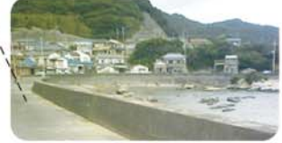
湾曲の海岸通り散歩道
